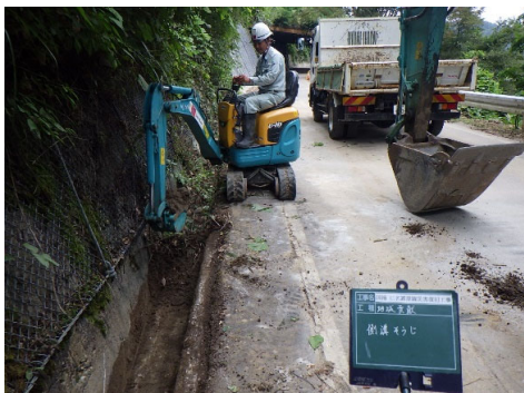
(側溝、路肩清掃)
