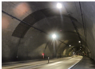
白馬長野有料道路トンネル修繕工 長野市日高トンネル
