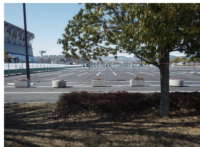
南長野運動公園第一駐車場整備工事 長野市篠ノ井
