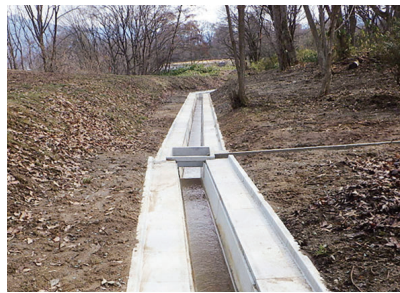
防災・安全交付金緊急改築工事 茶臼山
