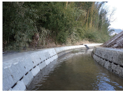
県営かんがい排水事業水路工事 埴科郡坂城町
