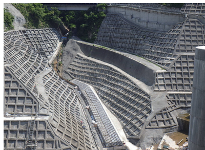
国補治水ダム建設事業に伴う 法面対策工事
