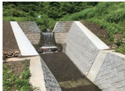
県単砂防工事 長野市上楠川 2019
