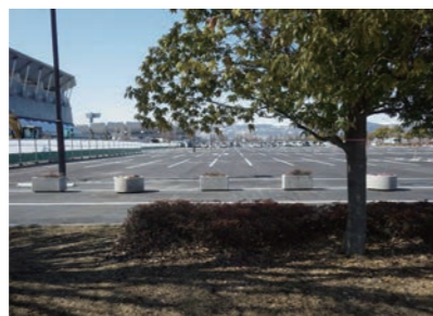
南長野運動公園第一駐車場整備工事 長野市篠ノ井 2014
