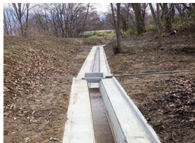
防災・安全交付金緊急改築工事 茶臼山 2019
