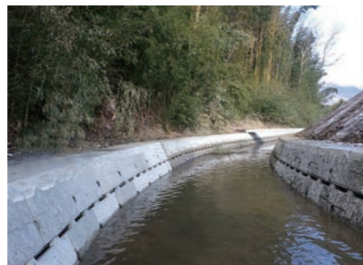
県営かんがい排水事業水路工事 埴科郡坂城町 2016
