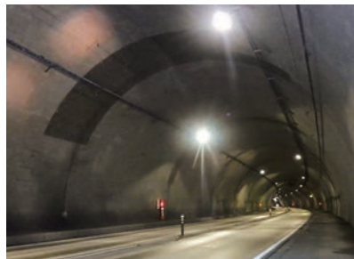
白馬長野有料道路トンネル修繕工 長野市日高トンネル 2020
