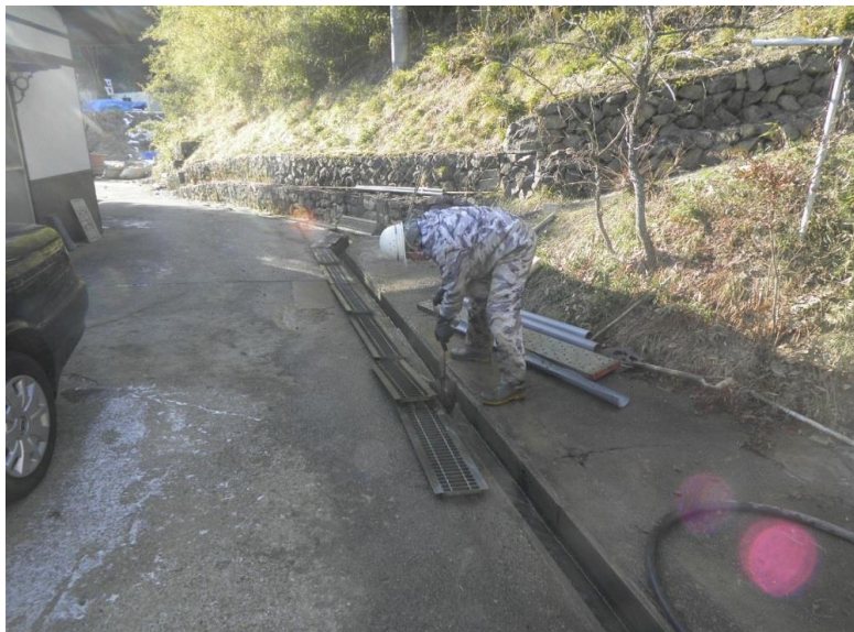
道路側溝の土上げ
